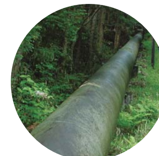
水圧管で山の上から水を供給している
