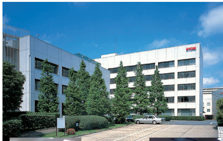
東日本支社 (リョービ東京支社内)
