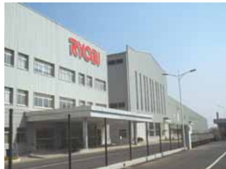
奥が第二期工事で増築した建物
