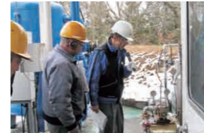
定期審査 (現場確認)
