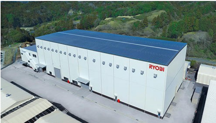
大型製品試作工場の外観(菊川工場)
